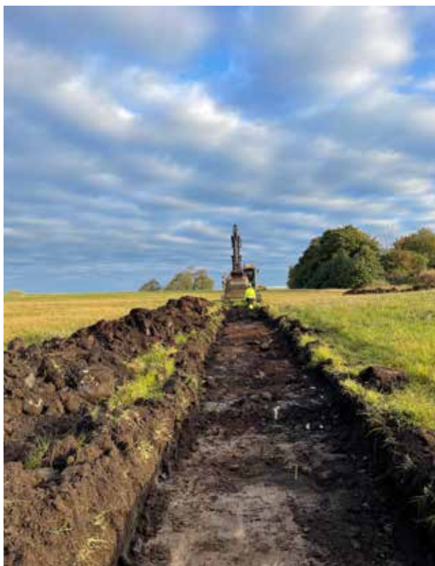
Figur 33. Översikt schakt 200, inom L2023:8276. Lina sköter arbetet vid maskinen. Mot N. Fotonr: 2025-3:001. Fotograf: Linda Wigert
